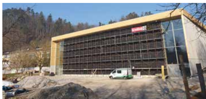
Gradnja Večnamenske športne dvorane Mengeš poteka v skladu s terminskim planom, zato tako investitor kot izvajalec, predvsem pa Osnovna šola Mengeš, pričakujejo, da bo športna dvorana v uporabi v šolskem letu 2020/2021
