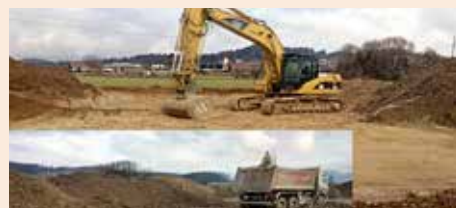
Izkop tik pod naseljem Križ (posneto 29. 1. 2020) s sliko materiala
