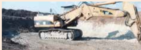
Izkop na območju Nazarij – zahodno od glavne ceste Mengeš–Duplica (fotografije prejel pisec prispevka z navedbo o močnem smradu, posneto 19. 1. 2020)
