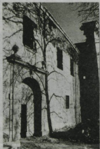
Obnovljeno in utrjeno zidovje na jugozahodni strani Brdskega gradu
