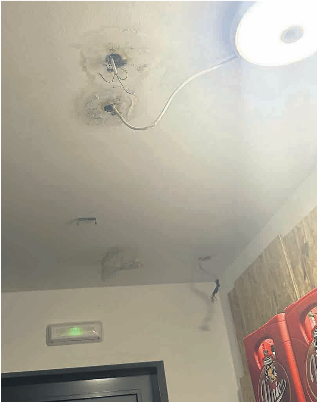
Streha zamaka, tik ob lučeh celo odpadajo deli ometa.
