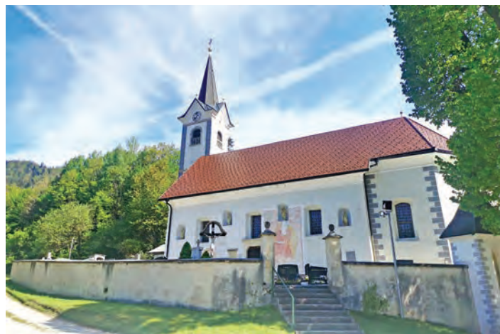
Cerkev sv. Ožbolta v Šentožboltu z obnovljeno zunanjo fresko blizu nekdanje šole.
