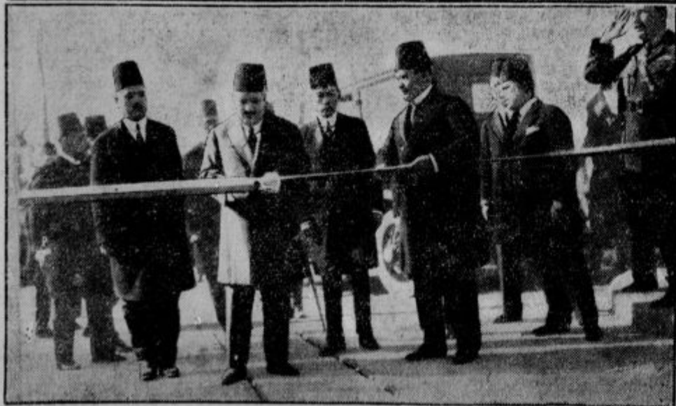
Orjaška zatvornica na gornjem Nilu. Kakor smo že poročali, je bila pred kratkim stavljena v promet nova velika zatvornica na gornjem Nilu pri Nag Hammadiju, s čemer se je tisočletni problem regulacije Nilovih poplav približal svoji rešitvi. Zgoraj: Pogled na zatvornico. — Spodaj: Kralj Fuad prereže trak pri svečani posvetitvi.
