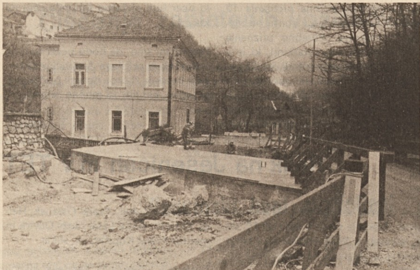
V Hrastniku so pred kratkim zgradili nov most čez potok Boben.
