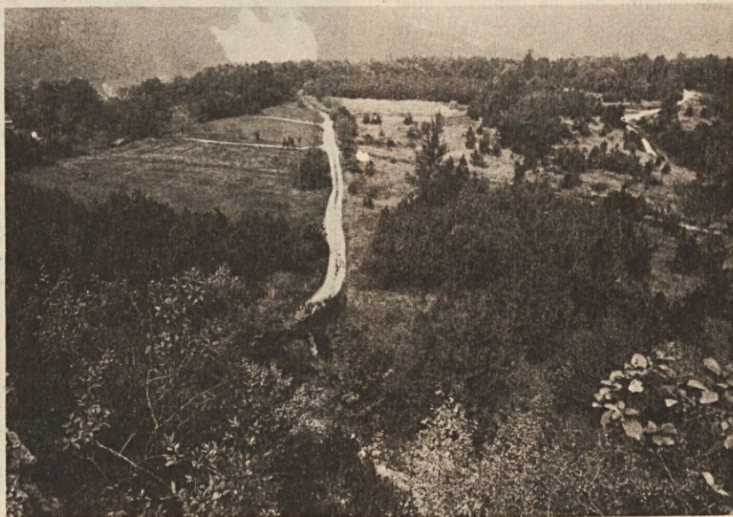
Področje Lakonce, kjer tečejo pripravljalna dela za nov površinski kop premoga. Posnetek je iz septembra t. l.
