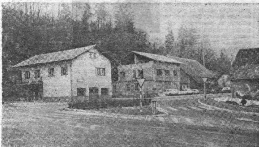
V Mostah so uredili križišče na Litijski cesti.
