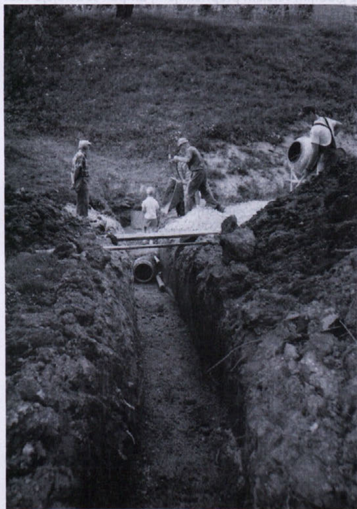
Priprava ceste pred asfaltacijo v Potoku. Foto: Darko Bogataj
