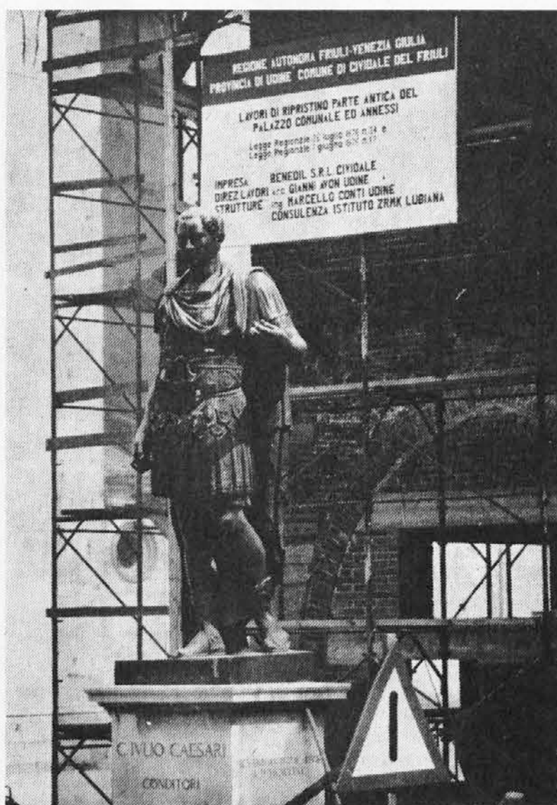
Občinska palača v Čedadu je zgodovinski center, ki ga popravlja s slovensko tehniko podjetje Benedil
