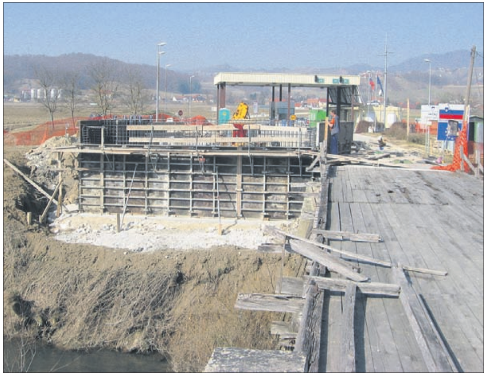
Gradbišče mostu ob slovensko-hrvaški meji na reki Sotli pri Imenem. Prvi potniki naj bi po njem zapeljali junija.
