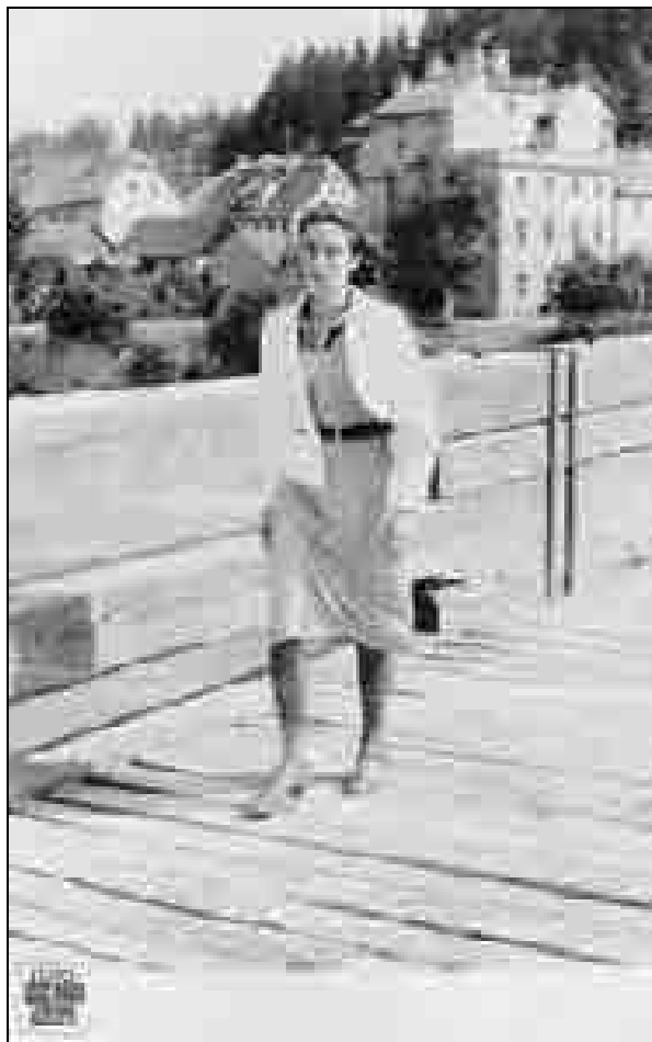
Riča na litijskem mostu leta 1939 (last avtorice).
