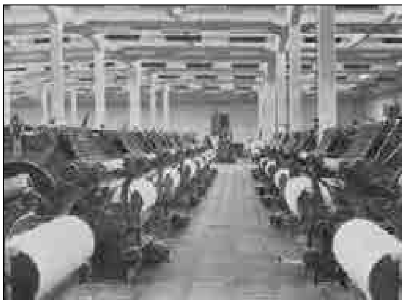
Mikalniki v novih prostorih po rekonstrukciji leta 1960. Stroji so bili predelani na posamični pogon, betonska tla je zamenjal parket (Kresal, Predilnica Litija 90 let, str. 37).
