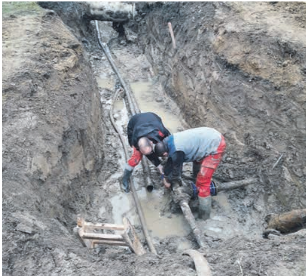
Obnova vodovoda v Dolenji vasi
