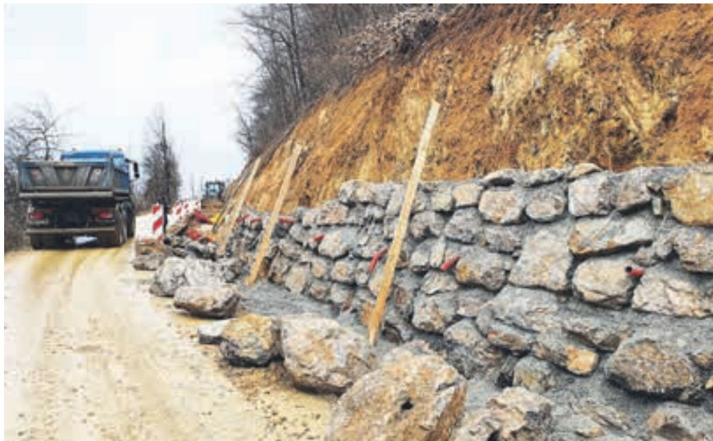
Zaradi žepov gline so morali brežino ob cesti na Koreno dodatno utrditi s kamnitimi zložbami in betonom.
