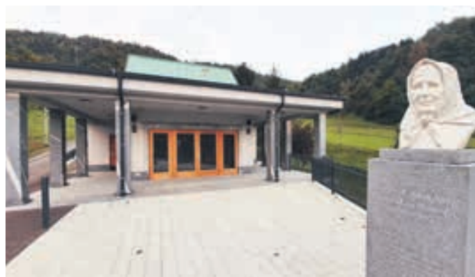
Zadnji dokončani objekt, pod katerega se je podpisal arhitekt Andrej Briški, stoji prav na Vrzdencu.
