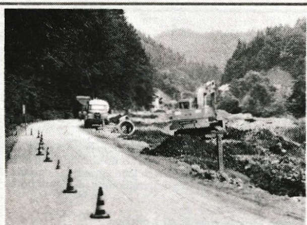
Meter po meter v Selški dolini - Lani začeta dela na postopni prenovi ceste v Selški dolini se letos nadaljujejo. Prenova ceste z odvodnjavanjem poteka domala po trasi sedanje ceste. S sprejetjem državnega proračuna pa naj bi v drugi polovici leta potekala tudi na nekaterih novih odsekih. - A. Ž.
