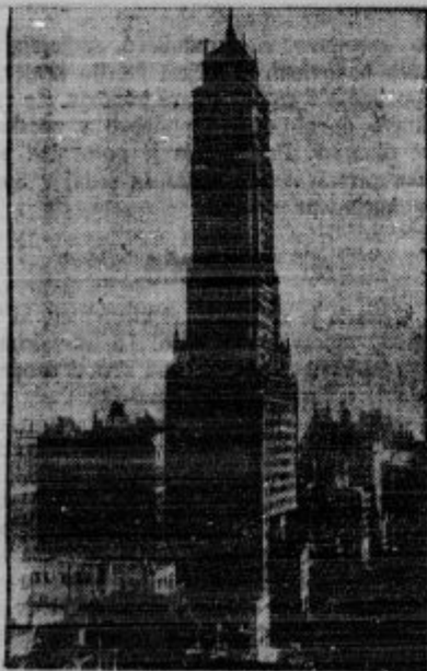
Zits-Tower-nebotičnik, najodličnejši newyorški hotel, ki ga je luda eksplozija v kletnih prostorih močno poškodovala. Gasilci so skušali udušiti požar in preprečiti nadaljnje eksplozije, kar se jim je tudi posrečilo. Dalj časa se ponavljajoče eksplozije so pa ubile pet gasilcev. Škoda znaša 40 milijonov dinarjev.
