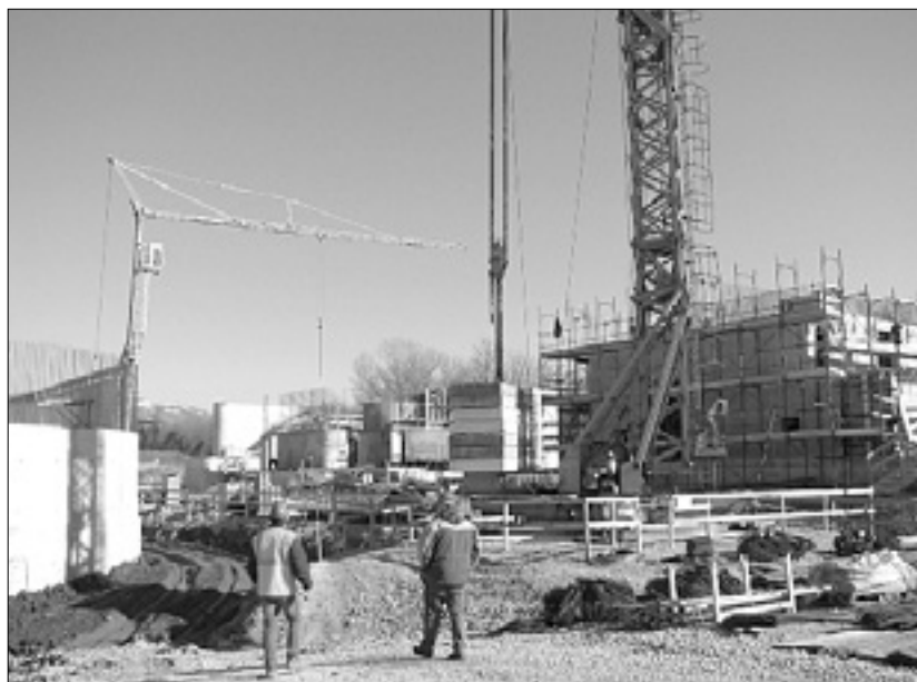
Gradbišče nove čistilne naprave v Vrtojbi
