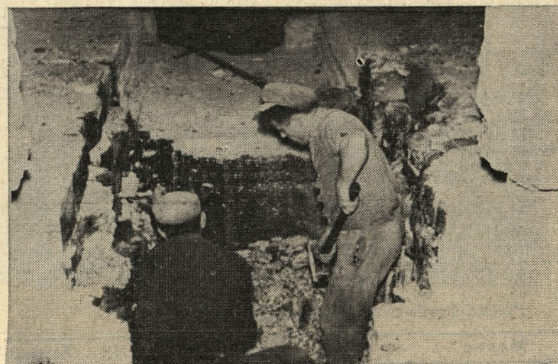
Zidarji pri popravilu lončene peči
