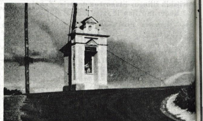
Javorjev Dol, 2. septembra - Sivkarjeva kapelica, kjer bo v nedeljo zahvalna maša ob zaključku investicijskih del v KS Sovodenj, slobo simbolično na koncu novega asfaltnega traku na grebenu med KS Sovodenj in KS Žiri. Slika: Š. Z.
