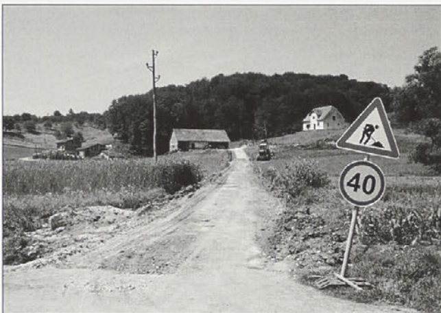
Fotka 1: V začetku julija začeli z zemeljskimi deli na cesti Furjan-Maliki ...
