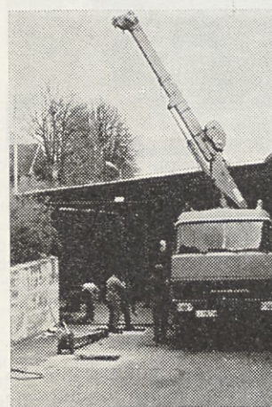
Montažna streha ob skladišču preje bo podaljšana.
