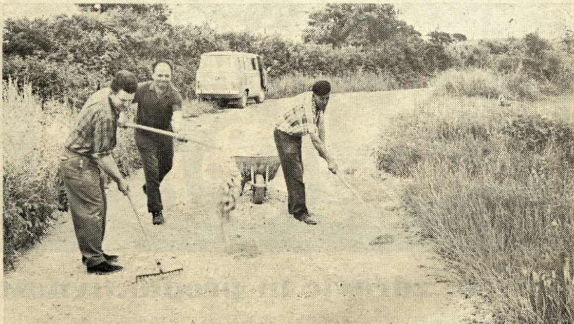
Nace popravlja cesto
