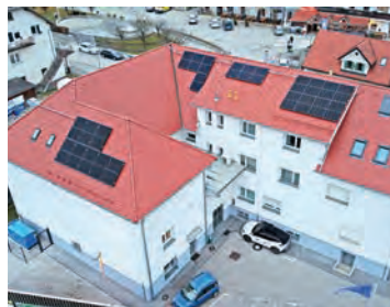
Sončne elektrarne na občinski stavbi.
