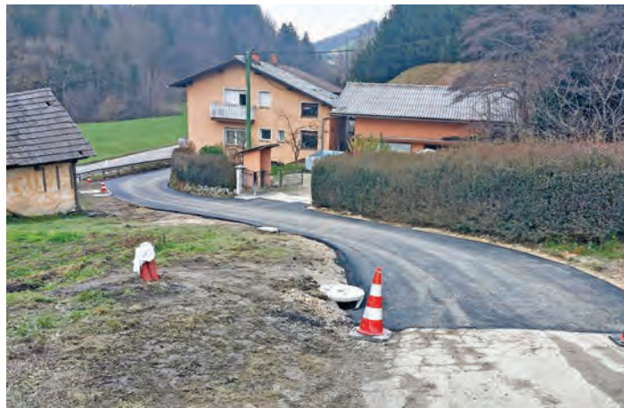
Obnovljen del občinske ceste proti naselju Hribi.
