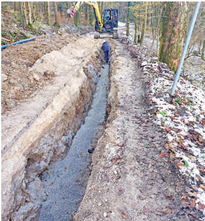
Rekonstrukcija javnega vodovoda na trasi Preserje pri Lukovici–Vrhe–Bobovnik.
