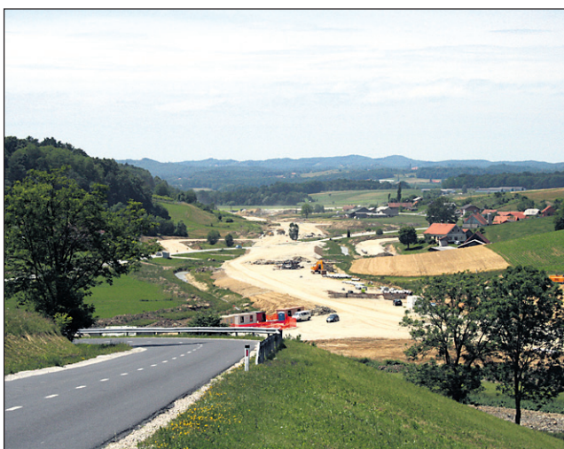
Gradbišče lokalni skupnosti zaenkrat ne povzroča večjih problemov, a čedalje več škode povzroča povečana gostota prometa.
