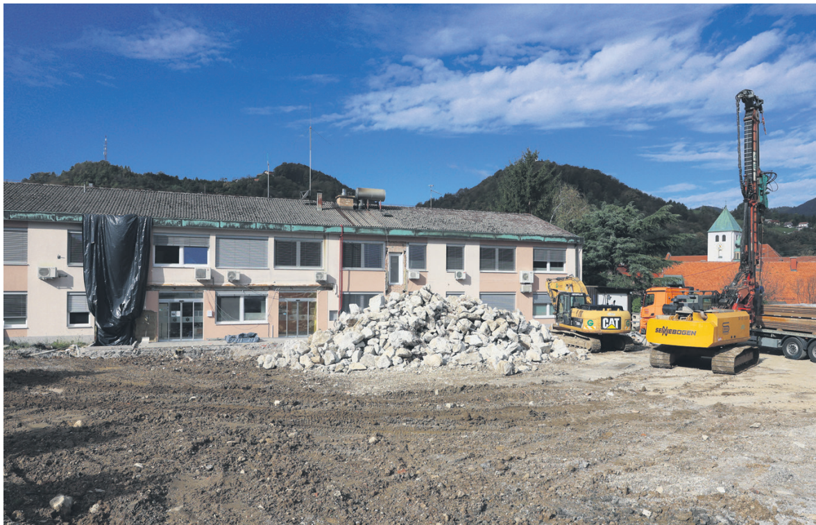
Potem ko so bila dela na gradbišču pri zdravstvenem domu približno mesec ustavljena, izvajalec gradnjo že nadaljuje. Tako naj bi bila predvidoma do konca meseca že zabetonirana temeljna plošča novogradnje.
