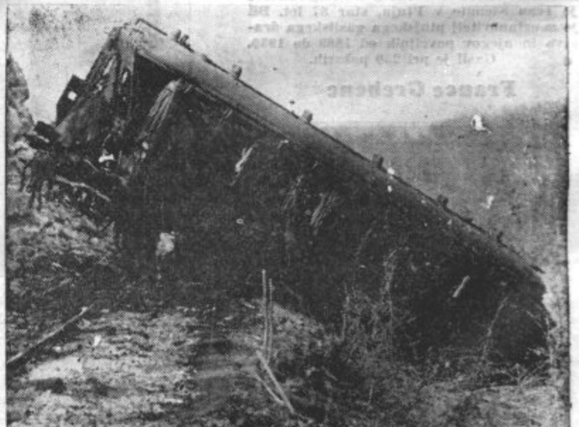
Zadnji izmed vagonov, ki so se iztirili, je obvisel na strmini. Potniki v tem vozu so bili najmanj poškodovani
