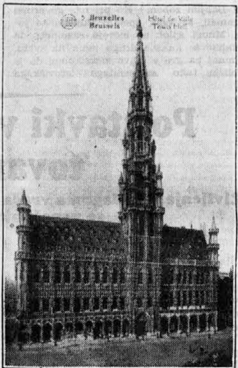
Rotovž na Grande Place
