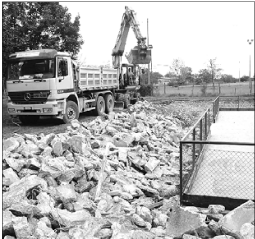
Poseg se je začel z rušenjem betonskih tribun
