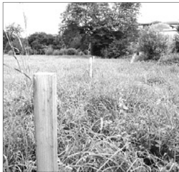
S količki so označili območje, kjer bodo zgradili nasip
