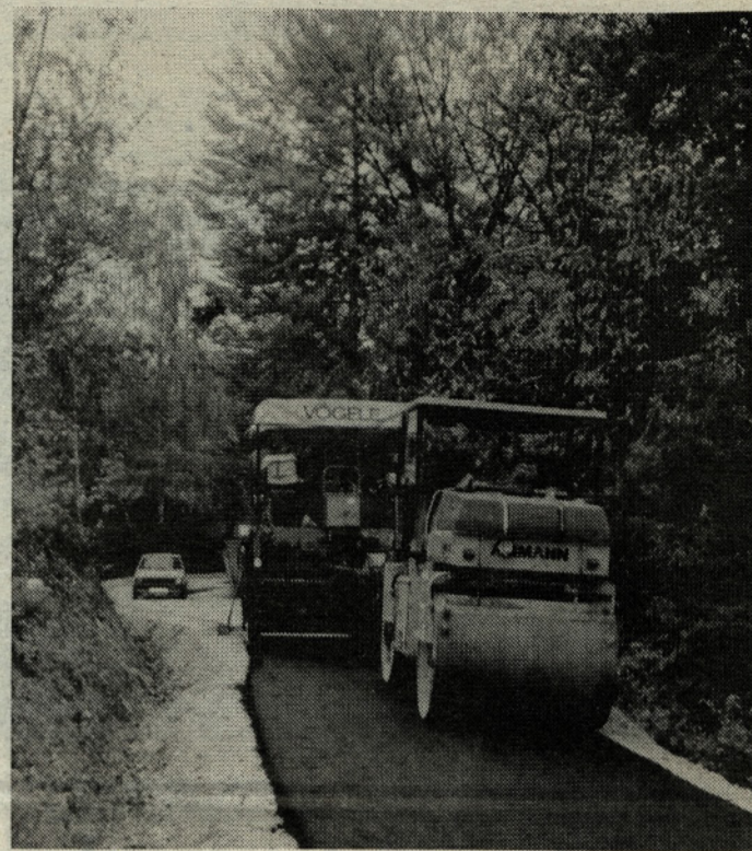
Med asfaltiranjem ceste na Brnico.
