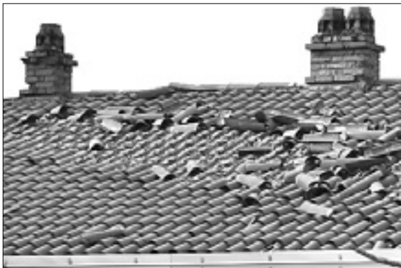
Streho zgoniške šole bodo temeljito popravili FOTO DAMU@N
