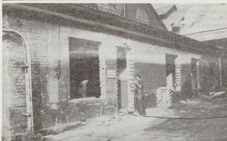
Sanacija prostorov obratovodstva Valjarne I
