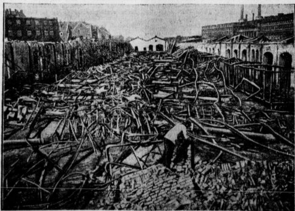
Požorišče na tovornem kolodvoru v Hannoveru, kjer je zvečer 30. avgusta izbruhnil ogromen požar, ki je vpepelil 150 deloma z raznim blagom naloženih vagonov.
