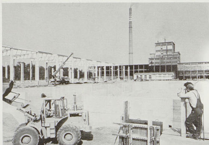
Temelji objekta za žganje anod
