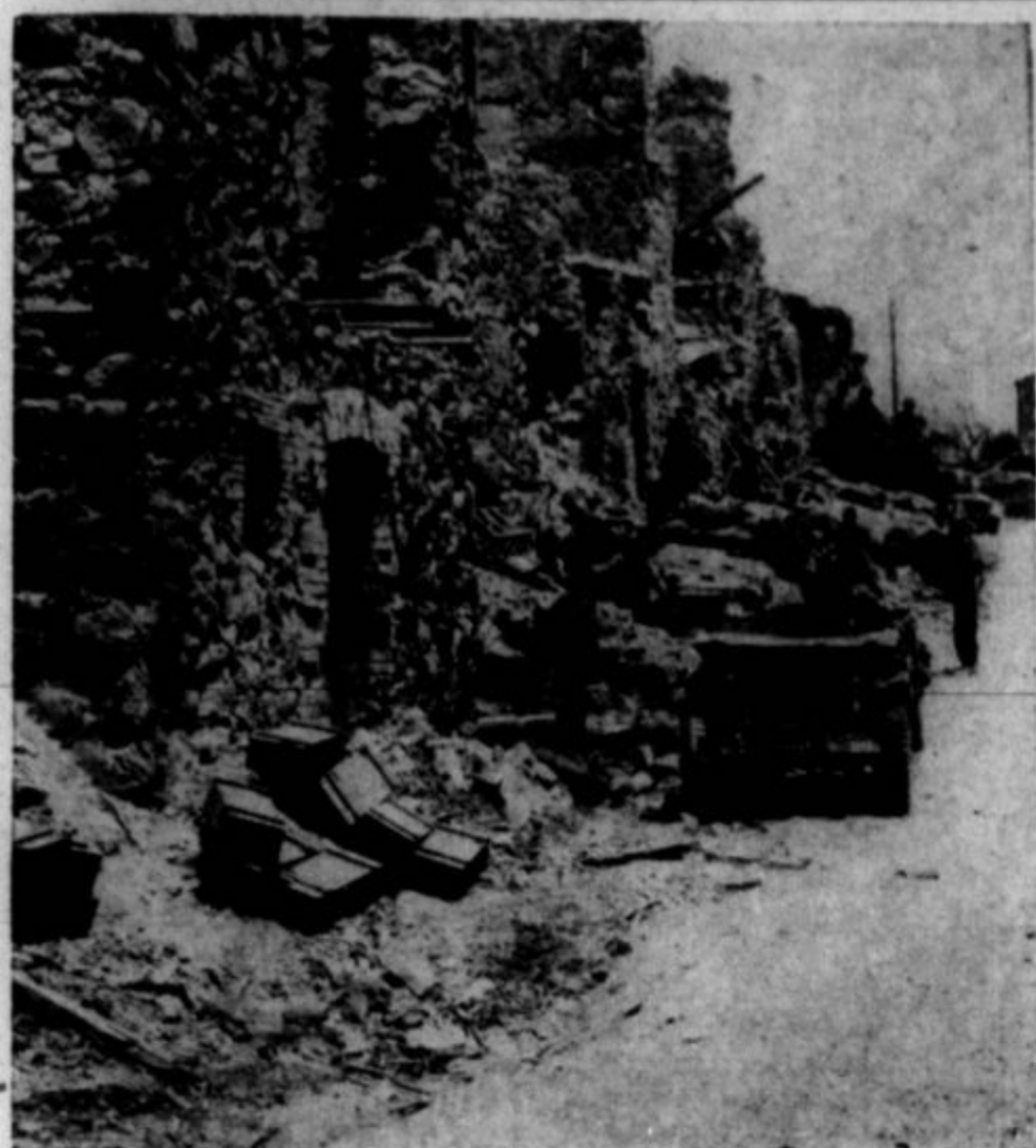
NAJVEČJI PROBLEM DEŽEL, v katerih divja voja, bo obnovitev porušeni mest in vasi. Gornje je slika iz Italije.
