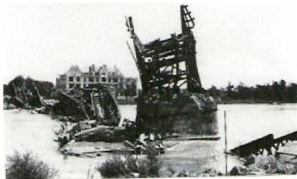
Ruševine mostu in poškodovana Mladika v ozadju.
