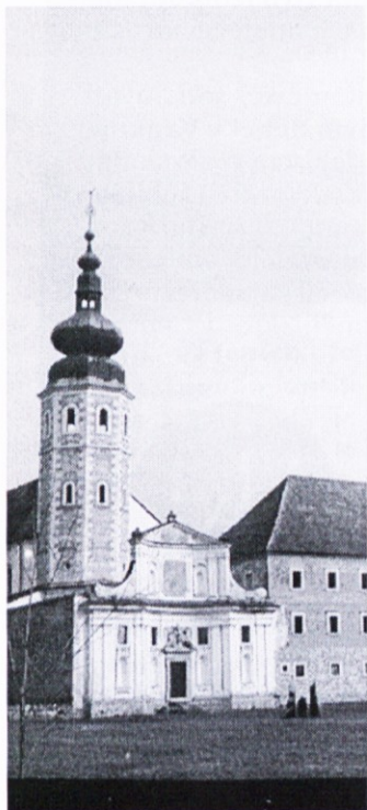
Zahodno pročelje kostanjeviškega samostana
