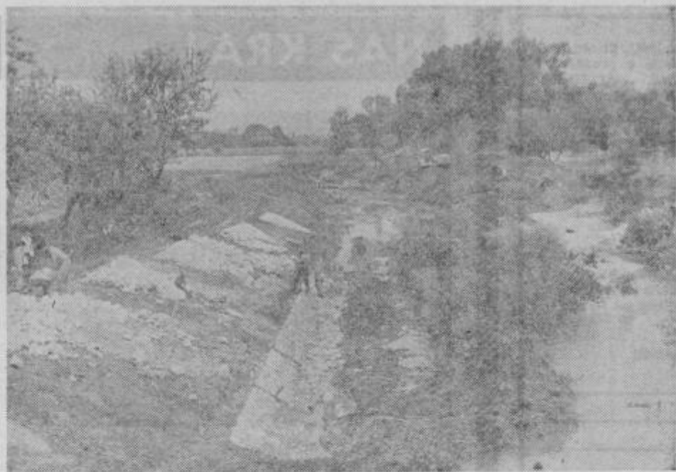
Potok Boljska, ki leta nazaj ob večjih nalivih poplavlja polja in tudi gospodarska poslopja ter hiše v krajevni skupnosti Gomilsko so pred dnevi pričeli regulirati. Dela izvaja NIVO iz Celja, predvidoma pa bodo končana prihodnje leto.
