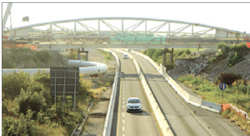
Jekleni lok pod mostom čaka, da ga dvignejo v zrak
