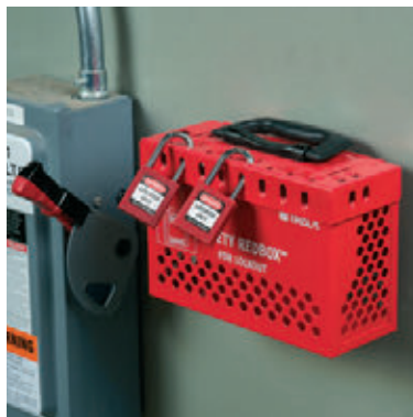
» Slika 4 in 5: Škatla za skupinsko zaklepanje preprečuje dostop do ključev obešk, s katerimi so zaklenjeni energijski izolatorji na delovni opremi. Ključe obešk na sliki morajo pooblaščen osebe seveda imeti pri sebi.
