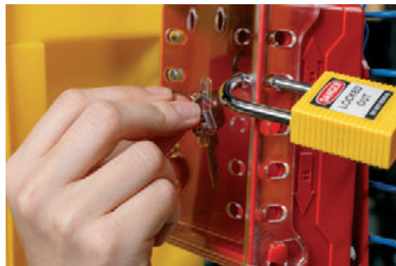
» Slika 4 in 5: Škatla za skupinsko zaklepanje preprečuje dostop do ključev obešk, s katerimi so zaklenjeni energijski izolatorji na delovni opremi. Ključe obešk na sliki morajo pooblaščen osebe seveda imeti pri sebi.
