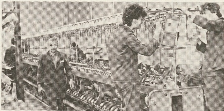
Montažna skupina pod vodstvom monterja iz Krušika Rajka Lažiča postavlja demontiran predilni stroj iz predilnice sintetike 2 v predilnico sintetike 3. Te prestavitve so potrebne zaradi montaže novih predilnih strojev iz Vzhodne Nemčije, v predilnici bombaža 2.
