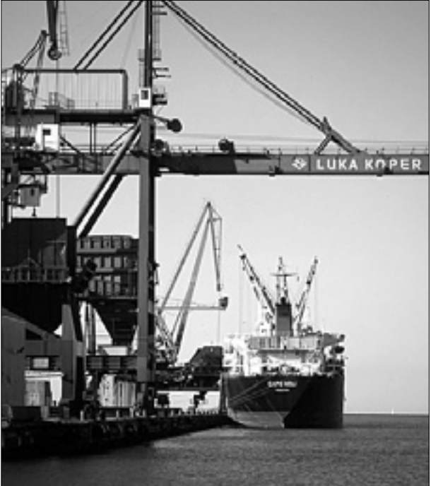
Prizor s kontejnerskega terminala v Kopru
