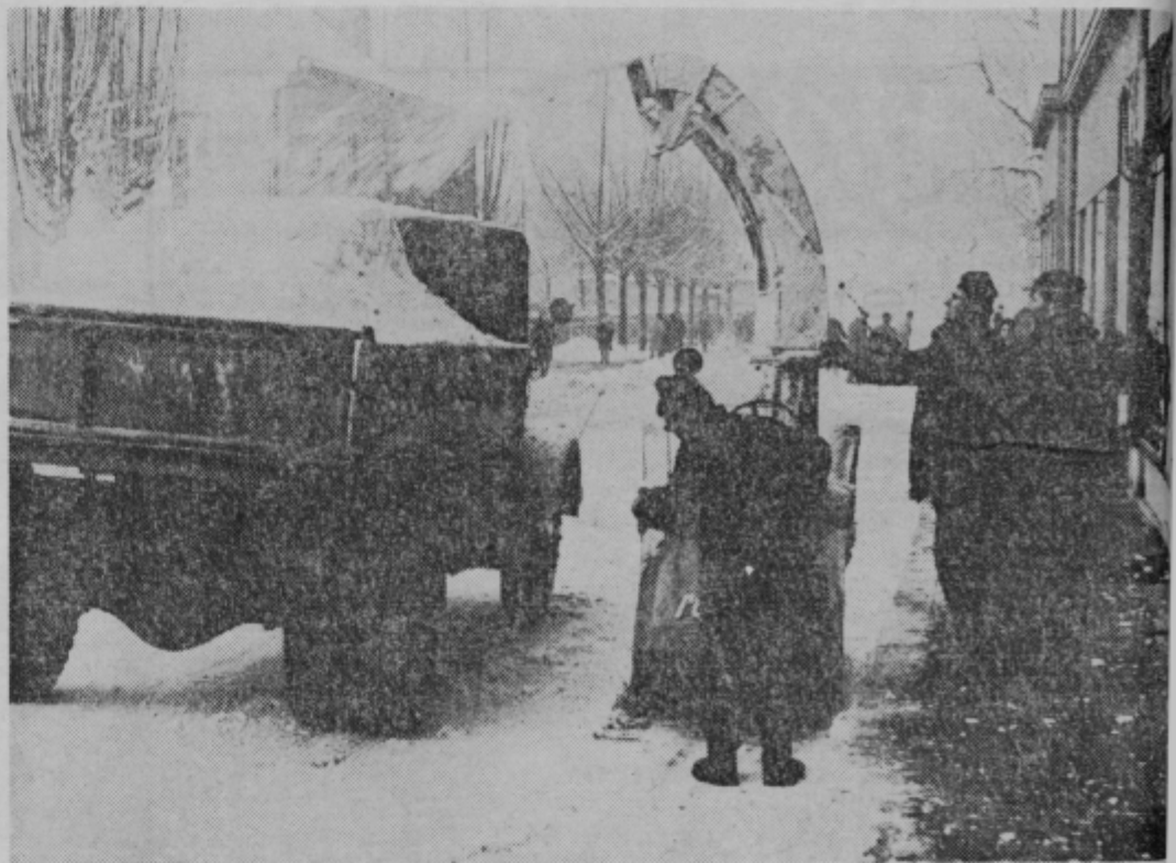
Kolektiv komunalnega podjetja Ceste-kanalizacije v Celju je za boljše in hitreje odstranjevanje snega z ulic kupil stroj za čiščenje snega. Gre za posebno rolbo, ki jo ročno upravlja en sam človek. Stroj pa dela kot sesalec, ki s pomočjo posebne cevi nalaga sneg na kamion. Naprava uspešno zlasti pri odstranjevanju takoj zapadlega in suhega snega. (Foto: M. Bo)
