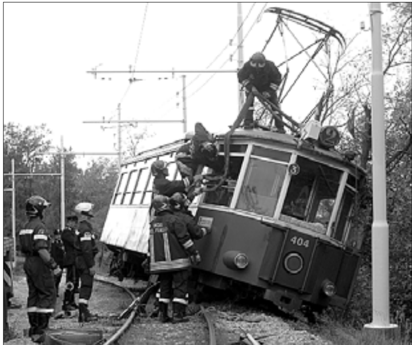
Od obnove proge je tramvaj večkrat iztiril. Na sliki: nesreča 24. oktobra 2004
