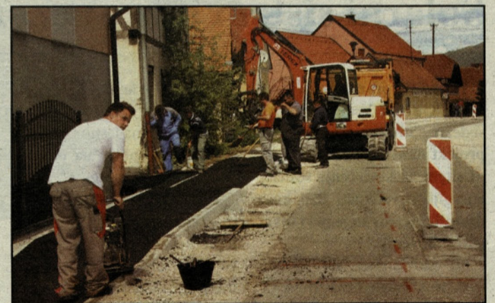
Takole so v Arji vasi zaključevali dela na novem pločniku
