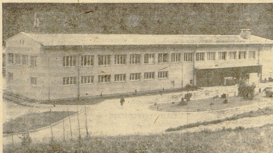
Pročelje naše tovarne elektromotorjev v Železnikih
