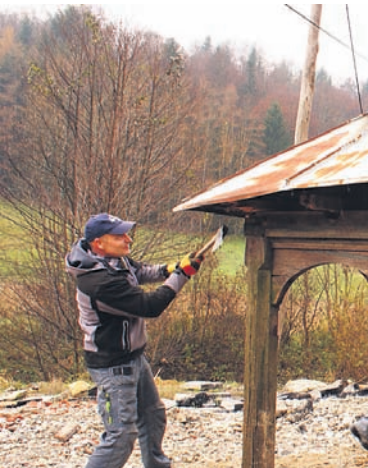
Jože Klinc in Andrej Maučič pri odstranitvi pilača novembra 2014.
