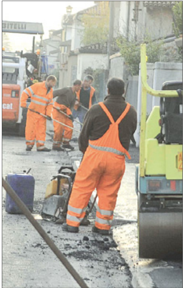
Delavci med včerajšnjim asfaltiranjem pločnika v Prvomajski ulici, pod katerega so vkopali optični kabel
