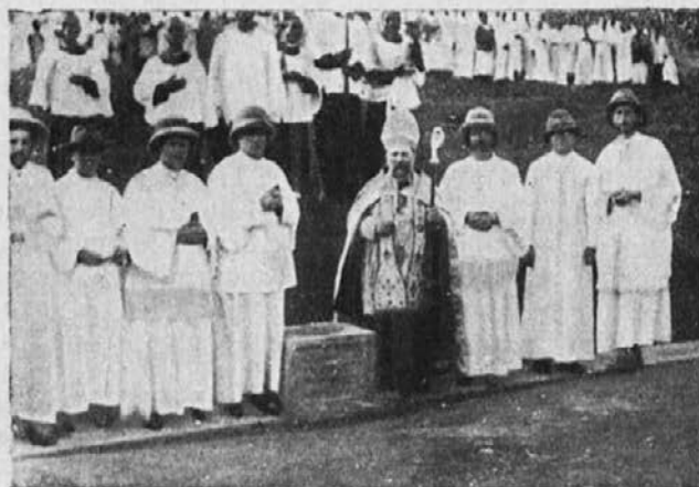
Blagoslovitev temeljnega kamna.
