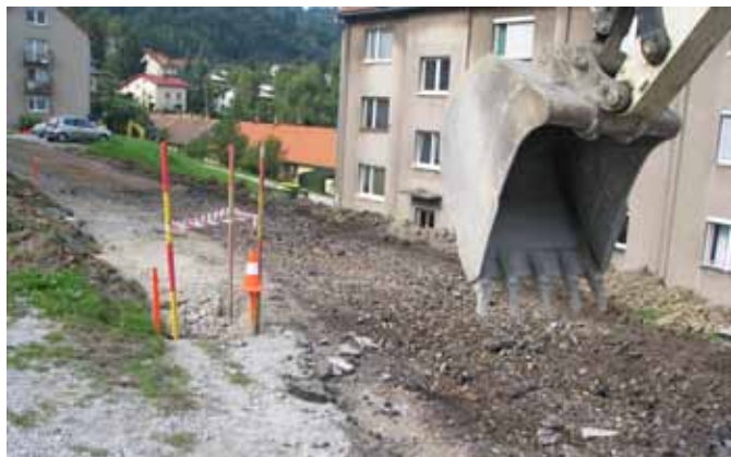
1) Rekonstrukcija Udarniške ulice na Lipi - Štore v dolžini 280 m.
