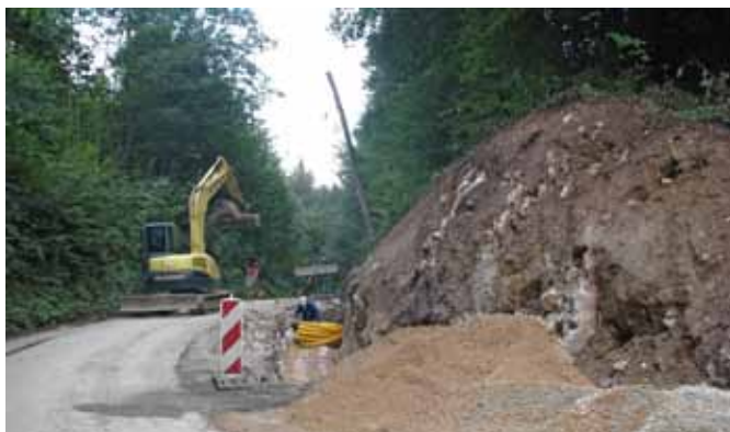
4) Rekonstrukcija lokalne ceste LC 036040 - Pečovje (sp. Pečovje - zg. Pečovje) v dolžini 530 m.
