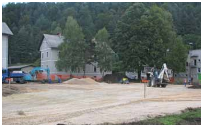
3) Izgradnja športnega igrišča v spodnjih Štorah.
