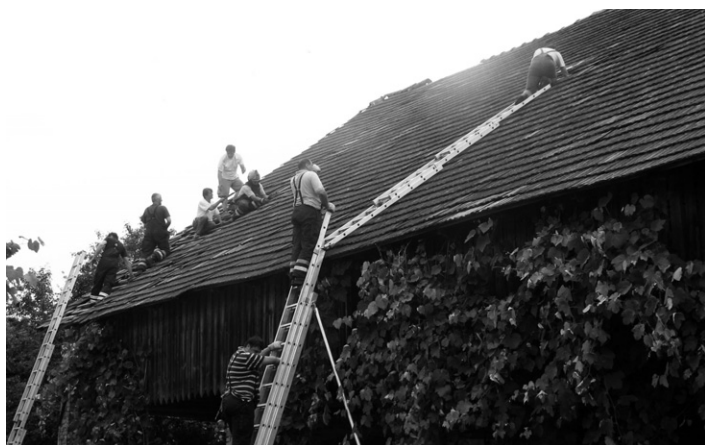
Čiščenje vozišča in priprava gasilcev za sanacijo streh
