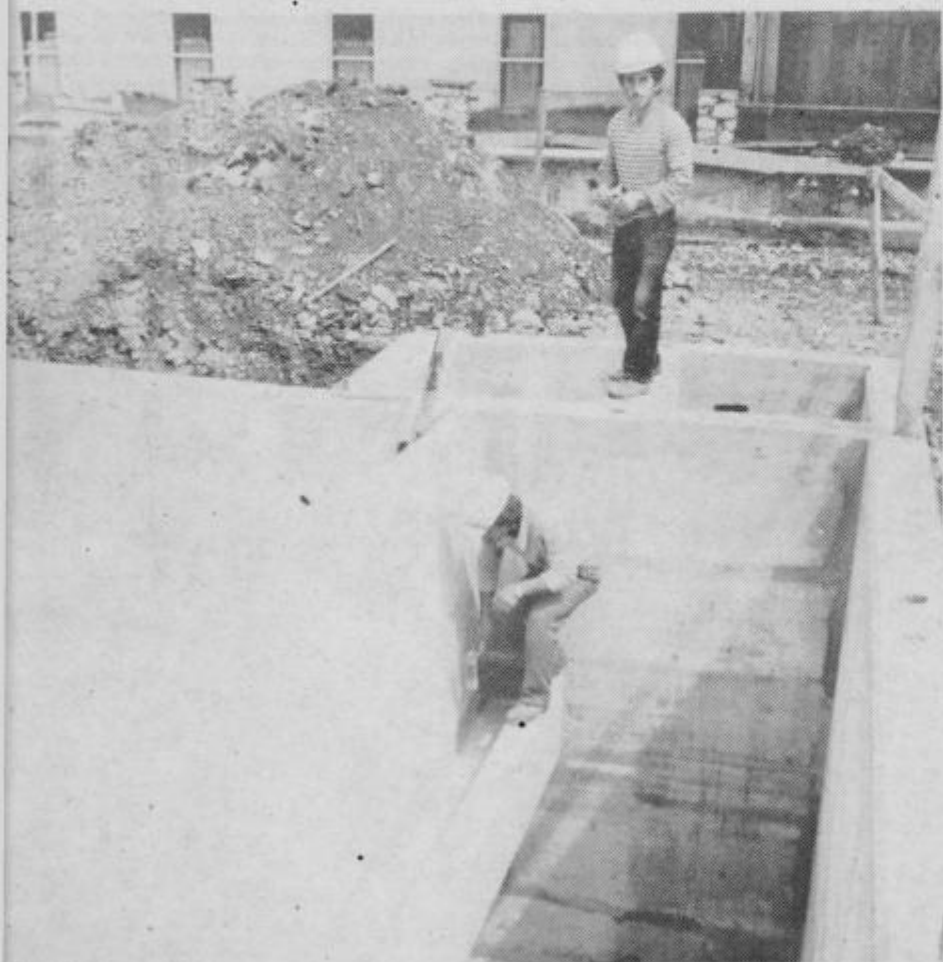
Delavci Nivoja Celje so kar mesec dni pred rokom zgradili bazen s čistilno napravo za odpadne vode iz barvarne.
