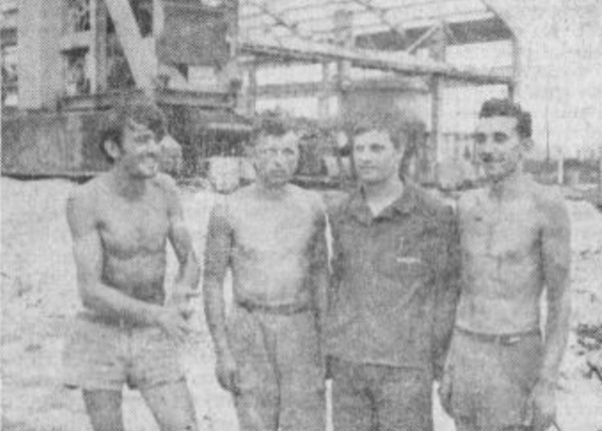
V skupini, ki je montirala več kot 60 betonskih lokov, so bili NIKOLA IVUSIĆ, IVAN SLAVIČEK, ADI OPERČKAL in DRAGO ILIĆ
